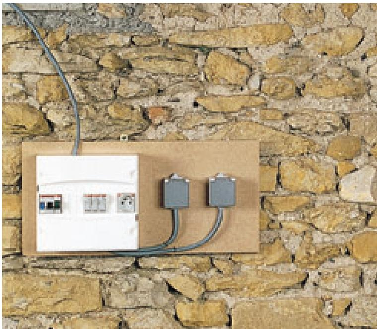
Lorsqu'on doit réaliser des travaux, il est nécessaire de disposer d'une alimentation électrique qui garantisse la sécurité. On réalise pour cela un petit tableau de chantier avec plusieurs prises afin de pouvoir raccorder les appareils électriques utilisés pendant les travaux : spot halogène pour l'éclairage, bétonnière, perceuses, etc.
